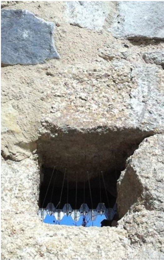
Detall d'una esclotxa de la muralla, amb claus. Foto: N.F.
