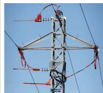
Aspecte d'una de les torres de mitja tensió on Endesa ha instal·lat aïllants per protegir les aus. Foto: EL PUNT.
