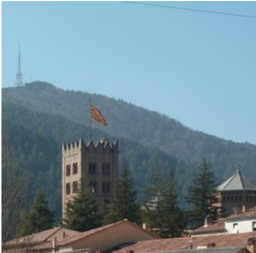
La zona de telecomunicacions del Catllar d'on l'Ajuntament en traurà rendiment. Foto: J.C.
