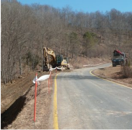
Un detall dels primers treballs que s'estan executant a la carretera de Beget. Foto: J.C.
