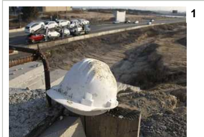
Les obres de l'N-II en el tram aturat entre Sils i Caldes. Foto: LLUÍS SERRAT.
