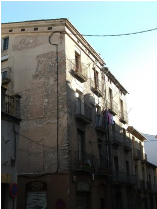
Un dels carrers del nucli històric on la brigada d'obres municipals està intervenint. Foto: J.C.
