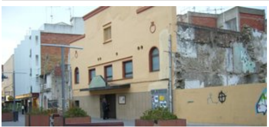
Façana de l'edifici de la SUF cedit a l'ajuntament per fer-hi un equipament cultural. Foto: M. V.
