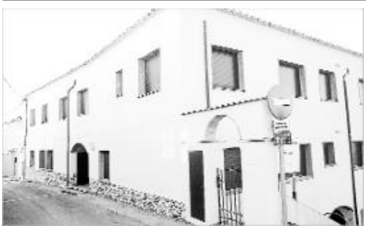
L'edifici Sant Ramon, part del qual s'ha de tirar a terra.
