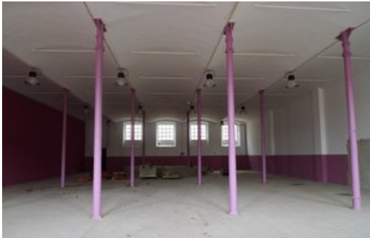
La nau de la Burés que s'ha rehabilitat i que serà una sala de ball. Foto: N. FORNS.
