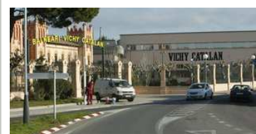
Instal·lacions de Vichy Catalan a Caldes de Malavella, amb la fàbrica i el balneari de costat Foto: JOAN SABATER / ARXIU.
