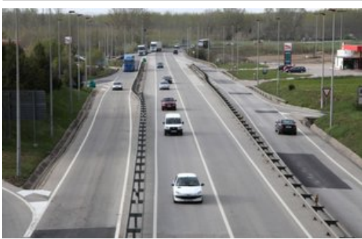
L'enllaç de l'N-II amb la C-35 i l'autopista entre Vidreres i Maçanet, ahir des del pont de la C-35. Foto: JOAN SABATER.
