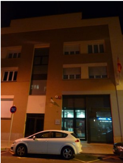
L'edifici que acull el Jutjat de Primera Instància i Instrucció de Ripoll, a la carretera de Barcelona. Foto: J.C.
