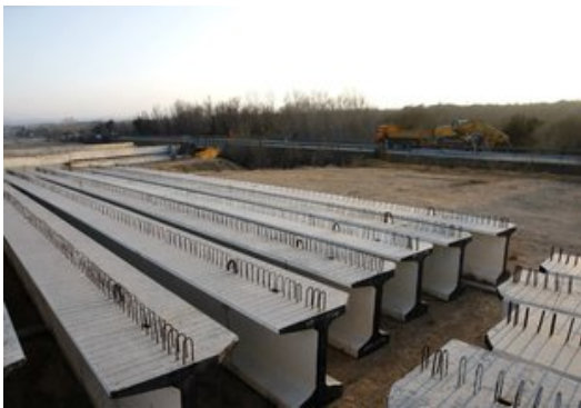
Obres aturades de l'N-II entre Sils i Caldes. Foto: LLU S SERRAT.
