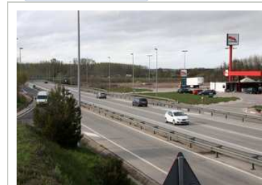
L'N-II entre Sils i Maçanet està pendent de l'aprovació del projecte. Foto: JOAN SABATER.
