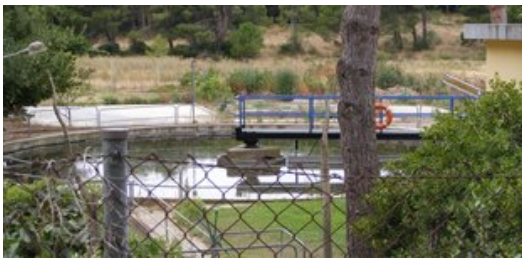
La depuradora de Begur continuarà funcionant fins que es construeixi la canonada Foto: A.V.
