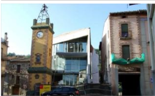
Imatge del nou edifici de l'ajuntament de Castellfollit de la Roca mentre encara estava en construcció.
