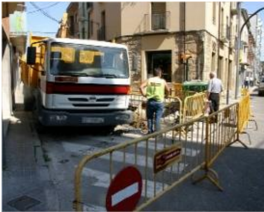
Urbanisme La millora del carrer Colom de Banyoles talla el trànsit
