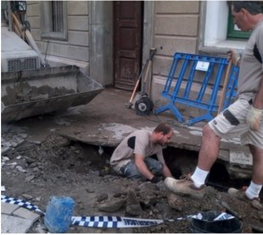
Els operaris arreglant la fuga.
