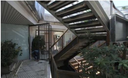
L'entrada a la discoteca, amb operaris substituint les portes, aquesta setmana Foto: E.A.
