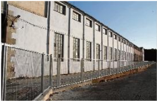
La tanca instal·lada que separa la Burés de la finca veïna.
