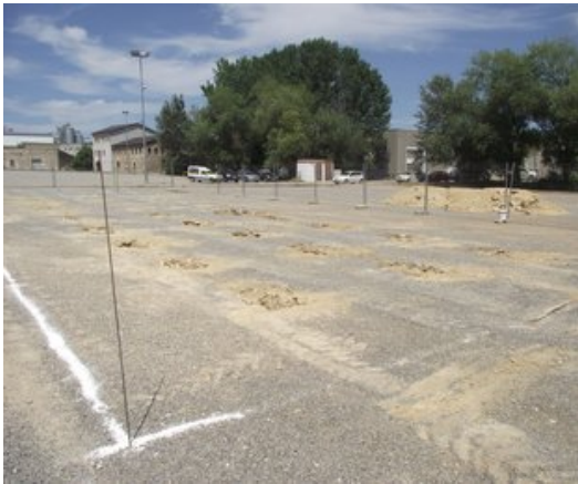
Una vista de les obres.
