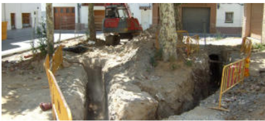
Les obres de la plaça prim van permetre redescobrir el refugi de la guerra civil.
