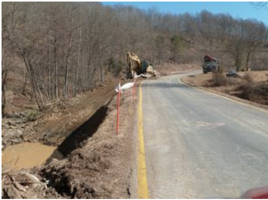
Les obres de la carretera continuen fins al Coll de la Boixeda i es reprendran al pont, sense tallar-lo. Foto: J.C.
