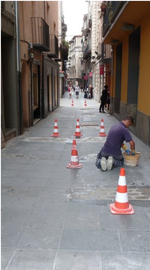
Un detall d'un operari reparant el paviment. Foto: J.C.
