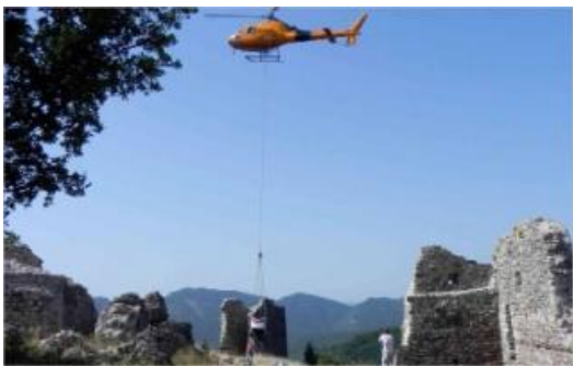
Imatge del transport aeri de material al castell, situat a 995 metres d'alçada.
