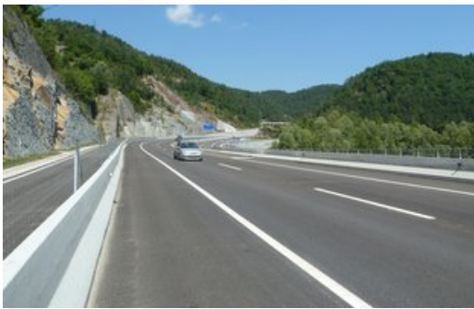
Una vista de la carretera C-17 desdoblada, al tram anterior a l'arribada a Ripoll. Foto: J.C.
