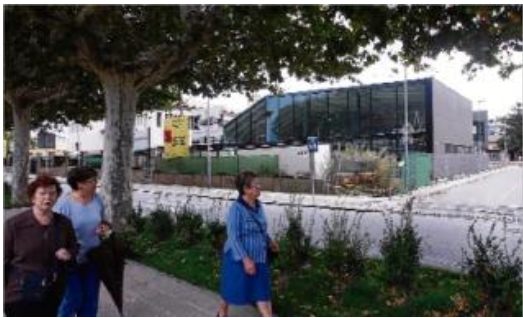
L'edifici de nova construcció, les obres del qual s'han de reprendre a finals d'octubre o principis de novembre.
