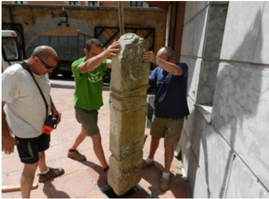
Treballs de col·locació de la fita a l'entrada de les Escoles Velles de Begur. Foto: EL PUNT AVUI.
