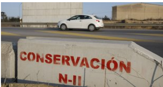
Les obres d'aquest tram, a l'alçada de Caldes. Foto: LLUÍS SERRAT.
