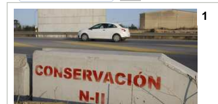
Les obres d'aquest tram, a l'alçada de Caldes. Foto: LLUÍS SERRAT.
