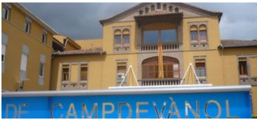
Una imatge de la façana de l'hospital comarcal del Ripollès, que està ubicat al municipi de Campdevànol. Foto: J.C.
