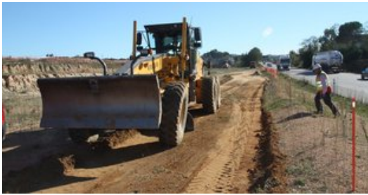
Una de les màquines que ha començat a treballar a la NII al seu pas per Caldes. Foto: ACN.
