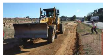
Una de les màquines que ha començat a treballar a la NII al seu pas per Caldes. Foto: ACN.
