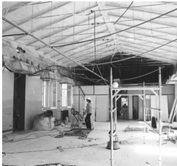
Aspecte de la part de l'ajuntament que es rehabilita. / M.B.
