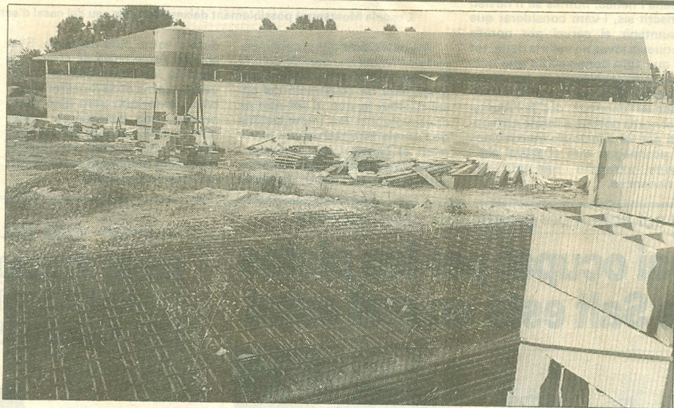
Un aspecte del pavelló polisportiu de Caldes, encara en construcció. (Foto RICARD CAMÓ).
