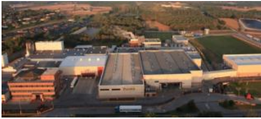
Puratos obre un centre d'innovació a la planta de Sils
