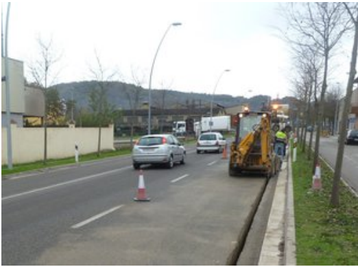
Un detall dels treballs que canalització del cable de fibra òptica, al nucli de la Canya. Foto: J.C.
