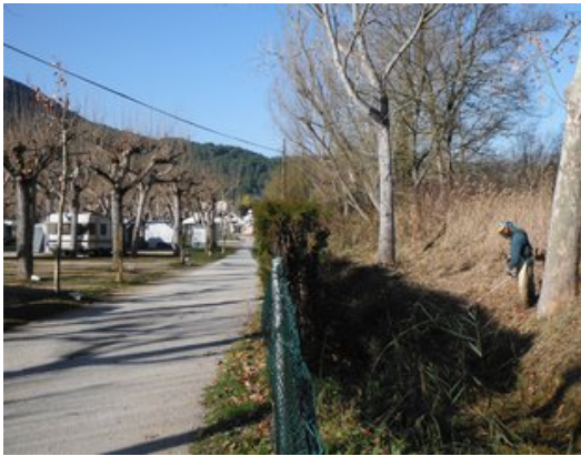
Un operari del COIET treballant a la riera del Marquès. Foto: EL PUNT AVUI.
