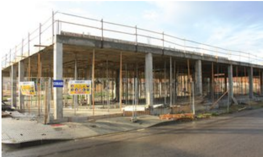
L'escola bressol de Pals, amb l'estructura inacabada. Tal com la va deixar l'empresa aturada. Foto: JOAN PUNTÍ.
