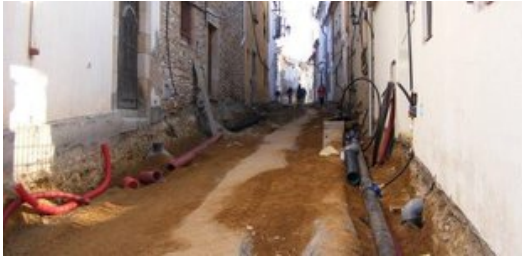
Obres de reurbanització i renovació de la xarxa d'aigua al carrer Vera, al 2011 Foto: AJ. DE BEGUR.
