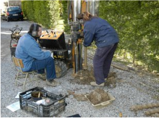
Treballs de sondeig del terreny de la mina d'aigua del palau Lo Mirador de Torroella de Montgr
