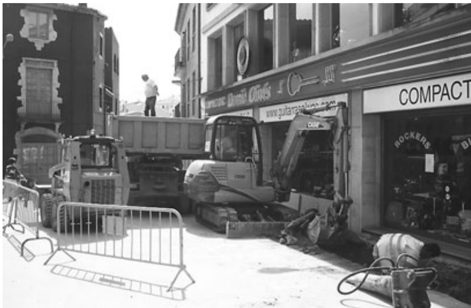
Obres a la cruïlla entre l'Hortal d'en Pou, de les Botines i Picasso, ahir al migdia. / A.V.
