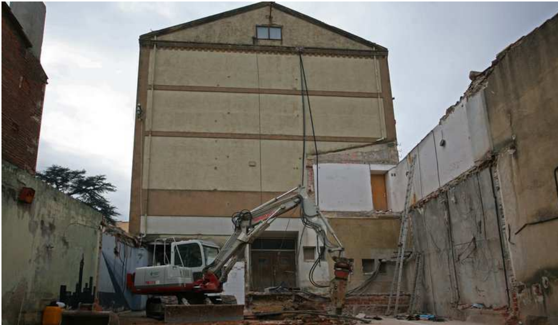
Una imatge de la remodelació del Centre Recreatiu de Cassà, divendres. Foto: LLUÍS SERRAT.
