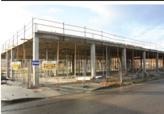
L'escola bressol de Pals, amb l'estructura inacabada. Foto: JOAN PUNTÍ.
