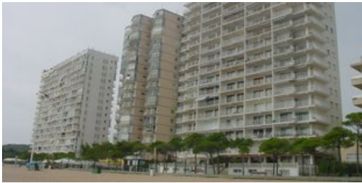
La víctima resideix en un habitatge de l'edifici Beach Palace, situat al passeig marítim (a la foto, el bloc de l'esquerra) Foto: J. T.
