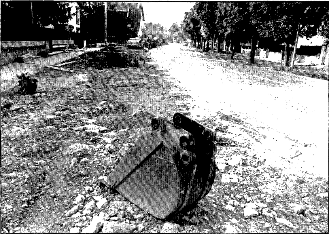
Les obres que s'estan efectuant actualment al passeig Mossèn Constans —a la imatge— reestructuraran totalment la infraestructura subterrània de la zona. (Foto PERE DURAN)
