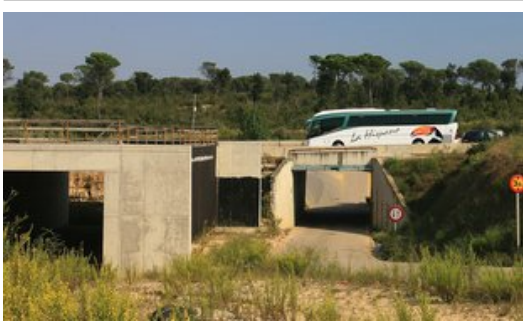
Les obres de desdoblament de l'N-II entre Caldes i Sils estan novament aturades. Foto: MANEL LLADÓ.
