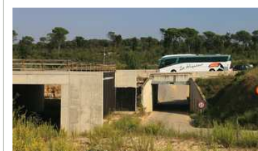
1 Les obres de desdoblament de l'N-II entre Caldes i Sils estan novament aturades. Foto: MANEL LLADÓ.
