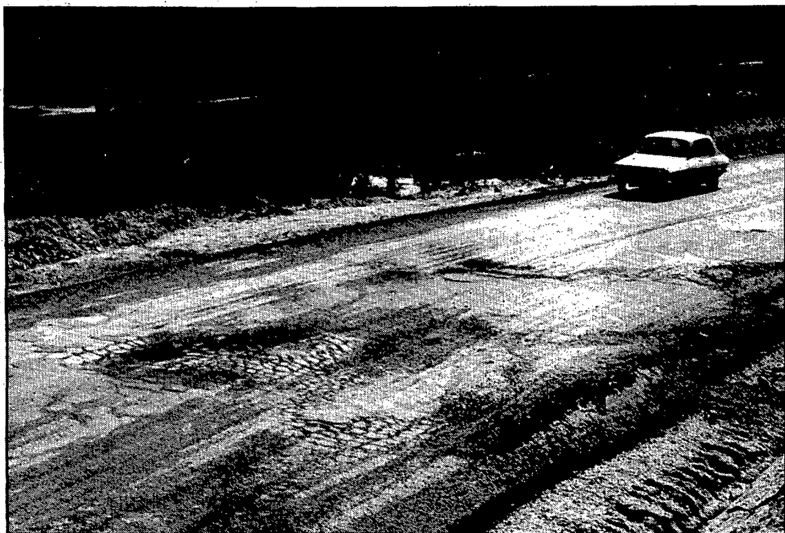
L'estat de la carretera que travessa Caldes i arriba fins a la N-II ha indignat els veïns. Les obres començaren la primavera passada i encara no s'han acabat.
