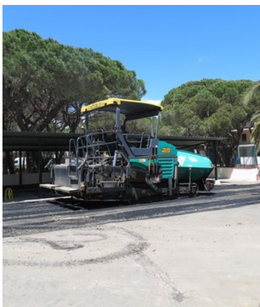
Les obres de reasfaltatge de carrers de Platja d'Aro es posen en marxa. Foto: EL PUNT AVUI.
